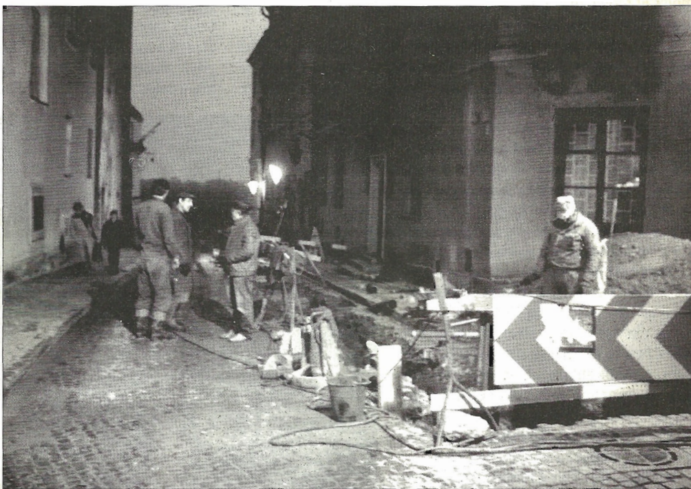
... A REMONT NAWIERZCHNI NALEŻY DO WOJEWODY
